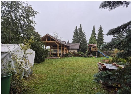
Foto 3: Anbau Schuppen (Foto SCZ)
