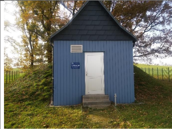
Abbildung 10 Trinkwasseranlage auf Flurstück 231/b an Gelenauer Straße.
